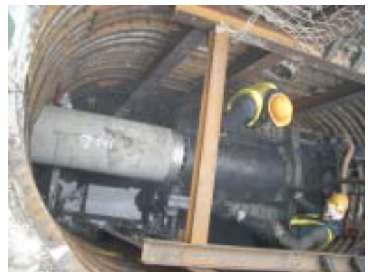
ヒューム管を圧入している様子
