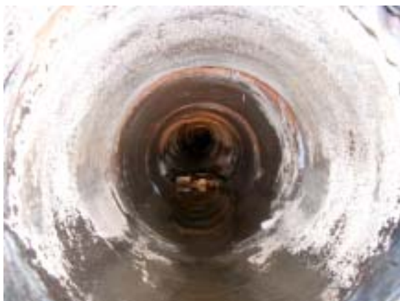
No. 2 ~ No. 1 の管内を見た様子
