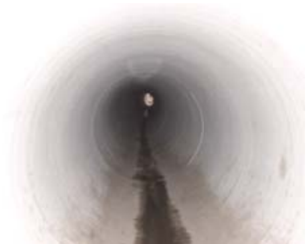
勾配が一定になっているのが確認出来る
