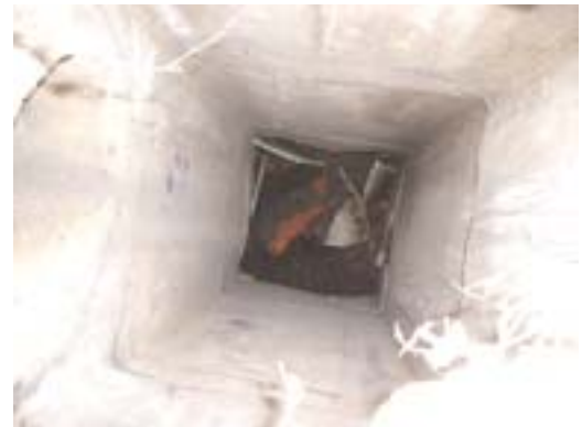
柵の障害を通過したクラッキングヘッド 陶管と柵のコンクリートを破砕しているのが確認出来る
