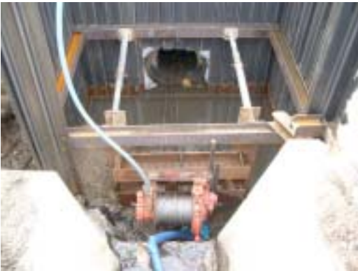
到達側、ウィンチ設置状況
