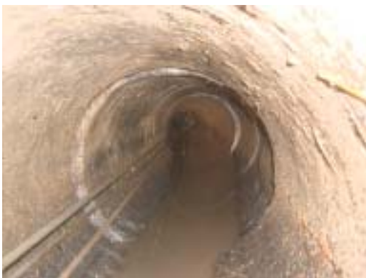
クラッキングヘッドを引っばっている様子 旧管が曲がっているため、ワイヤーが真っ直ぐ 引けず左側によっている
