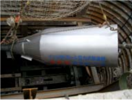
クラッキングヘッド吊りおろし状況
